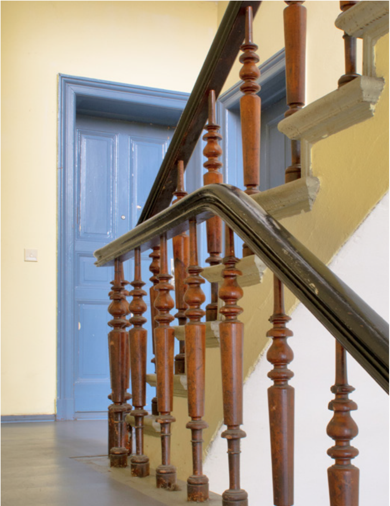
Treppenhaus und Wohnungstür
